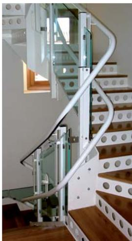
Los tubos de guía (50 mm de diámetro) pueden ser usados de barandilla ya que son totalmente cilíndricos.
