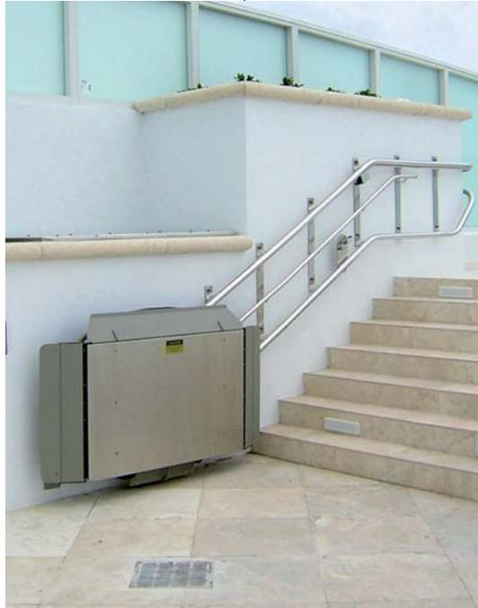
El panel de control está colocado en la parte superior de la espalda de la plataforma y consiste en dos pulsadores iluminados de dirección (subida y bajada) y uno de parada de emergencia.
